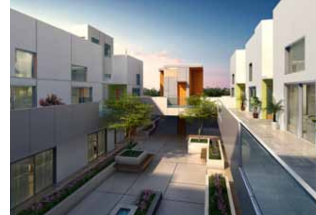
上/オープンテラスでカリフォルニアの温暖な環境を心ゆくまで楽しみたい。下/共有スペースとなる中庭には水と緑の豊かな空間が広がっている。
